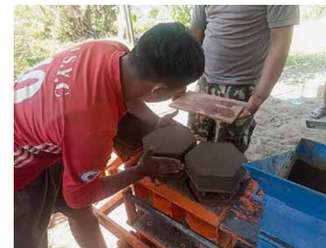
28 Personen werden angeleitet, die Bausteine herzustellen. Danach wird das Wissen im Rahmen unseres 108-Häuser-Projektes weitergegeben.
