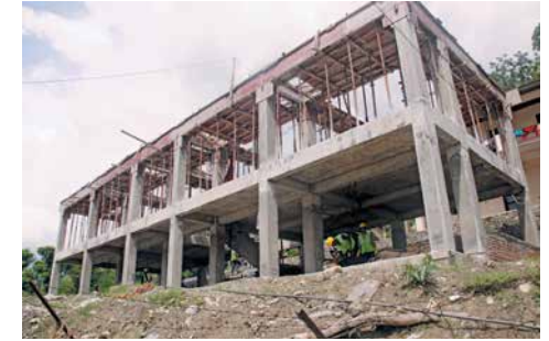
Juli 2019: Zweites Gebäude am Entstehen.
