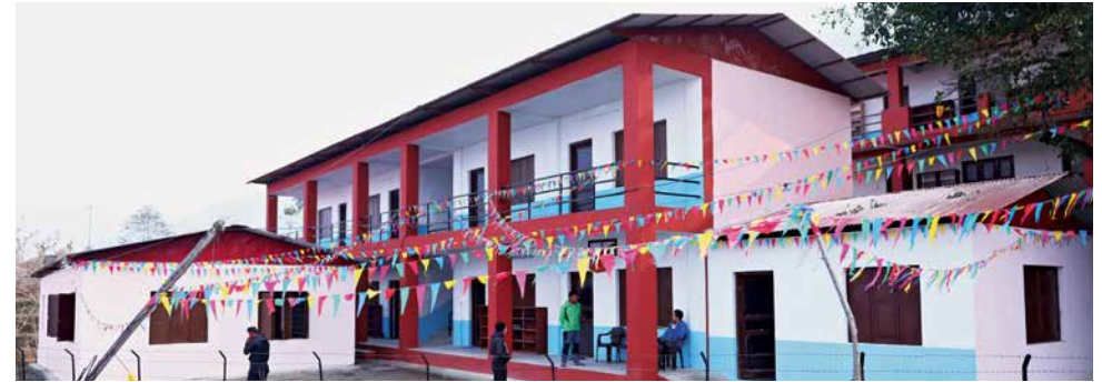
Februar 2021: Himali Chhatrabas ist fertiggestellt.
