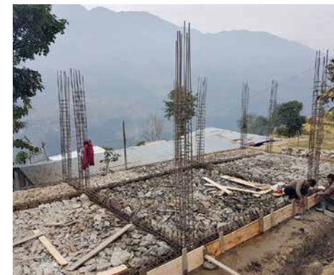
Nov. 2016: Fertiges Fundament des ersten Gebäudes.
