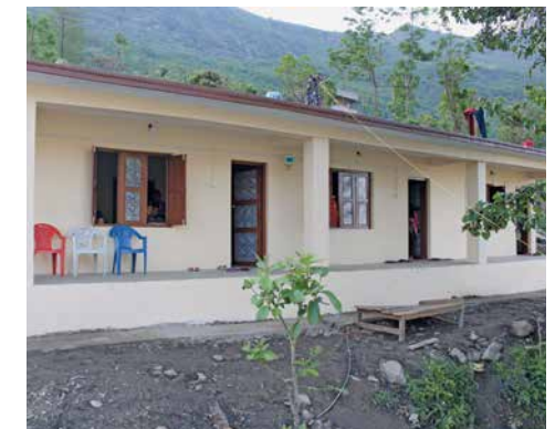
Mai 2017: Erstes Gebäude fertig (für 40 Schulkinder).
