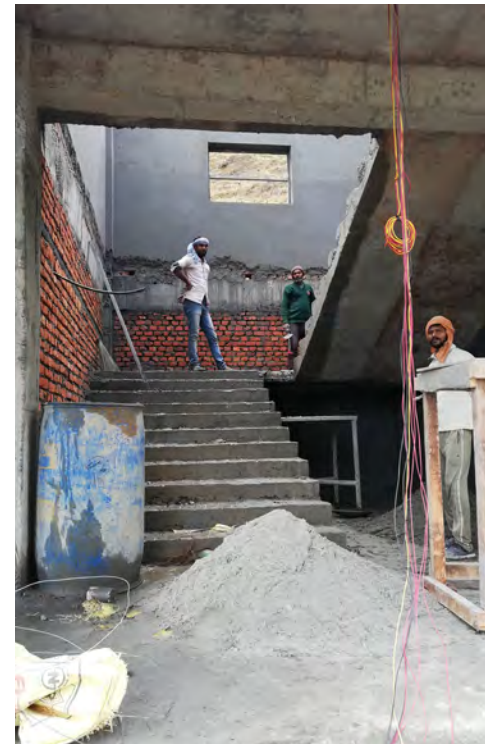
Januar 2020: Das Erdgeschoss steht ...
