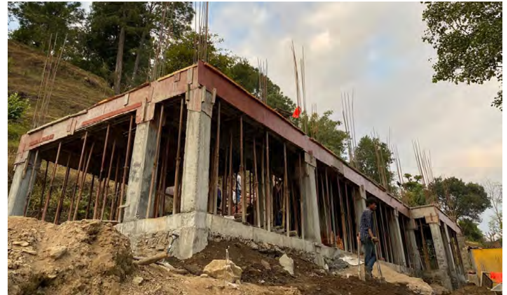
Dezember 2019: Für das erdbebensichere Gebäude sind die Pfeiler und Armierungen hochgezogen.
