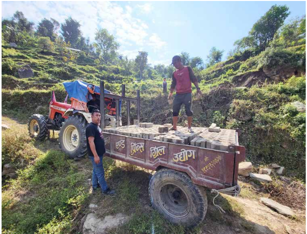
Transport von der Produktion zur Baustelle.
