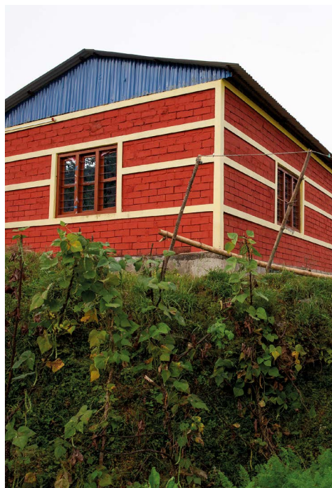
Ein Familienhaus mit Interlocking Bricks und Biogas-Installation.
