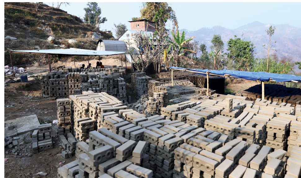
In Handarbeit: Die Interlocking Bricks.
